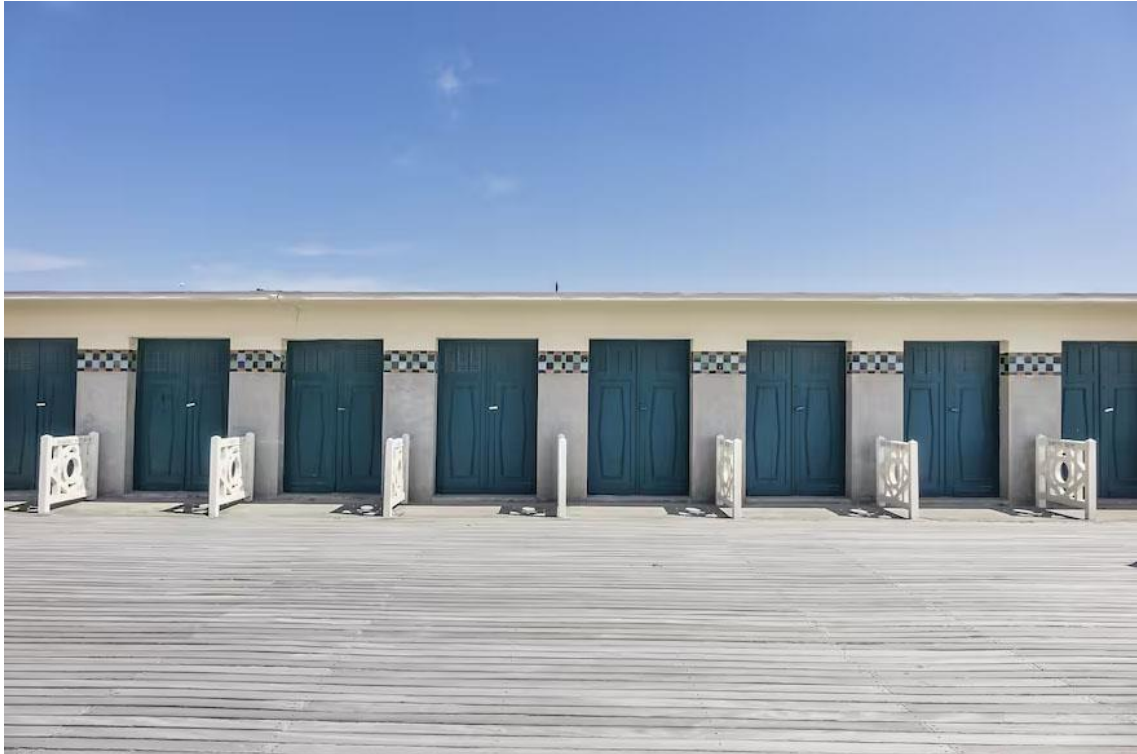
Vista de la pasarela de las planchas y vestuarios de playa en Deauville, Francia. Crédito: Kiev.Victor - Shutterstock.
